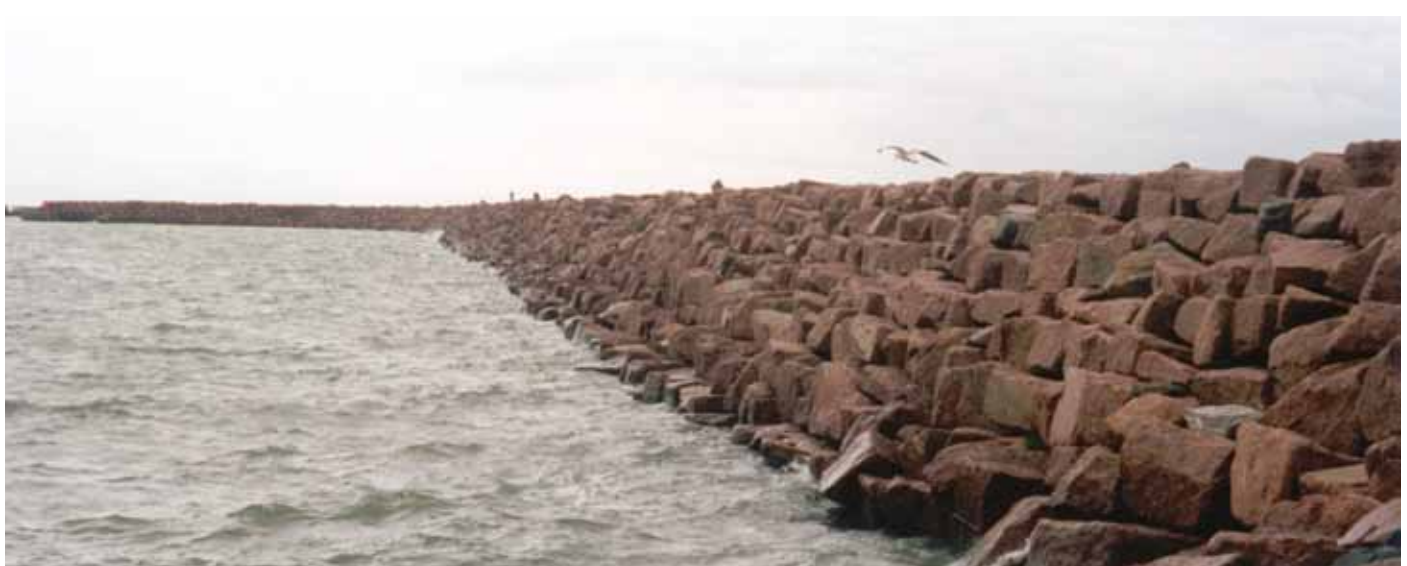
Kuva 10. Luonnonkivilouhimon sivukivi soveltuu niin ympäristö- (oikealla) kuin vesirakentamiseenkin (alla). Kuvat: Olavi Selonen (oik.) ja Palin Granit Oy.
